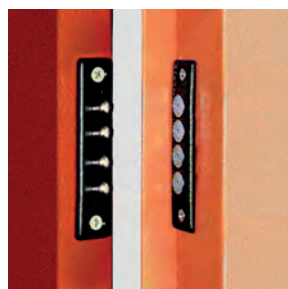
Contatti elettrici tra anta e telaio
